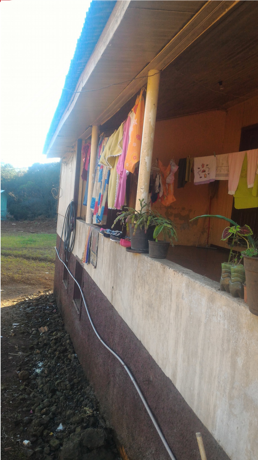
Foto 03: Condições gerais do piso e pintura.
