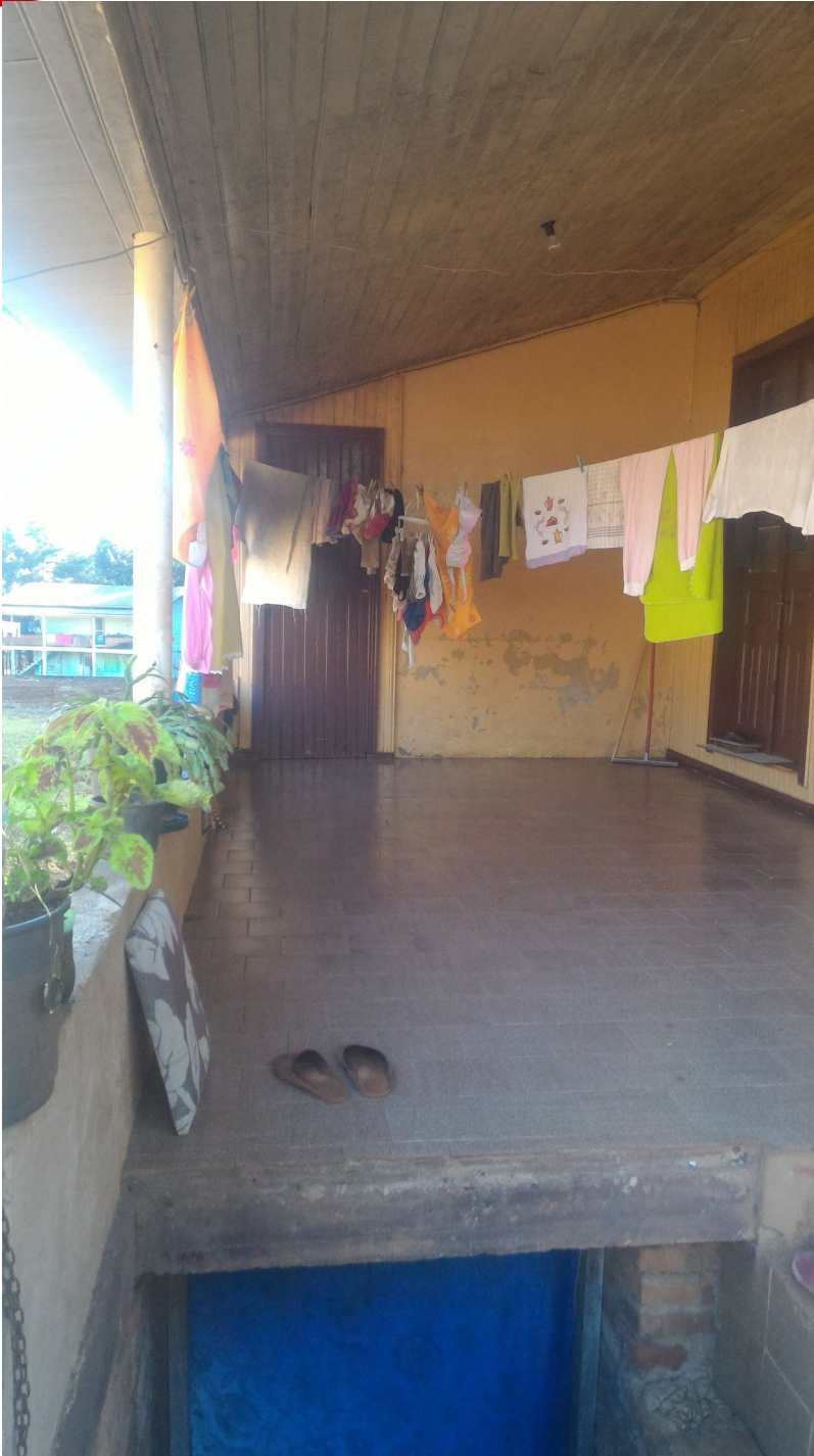
Foto 02: Condições gerais do piso e pintura.
