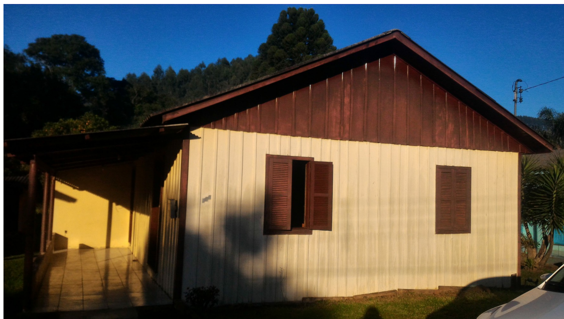
Foto 01: Condições gerais da edificação.
