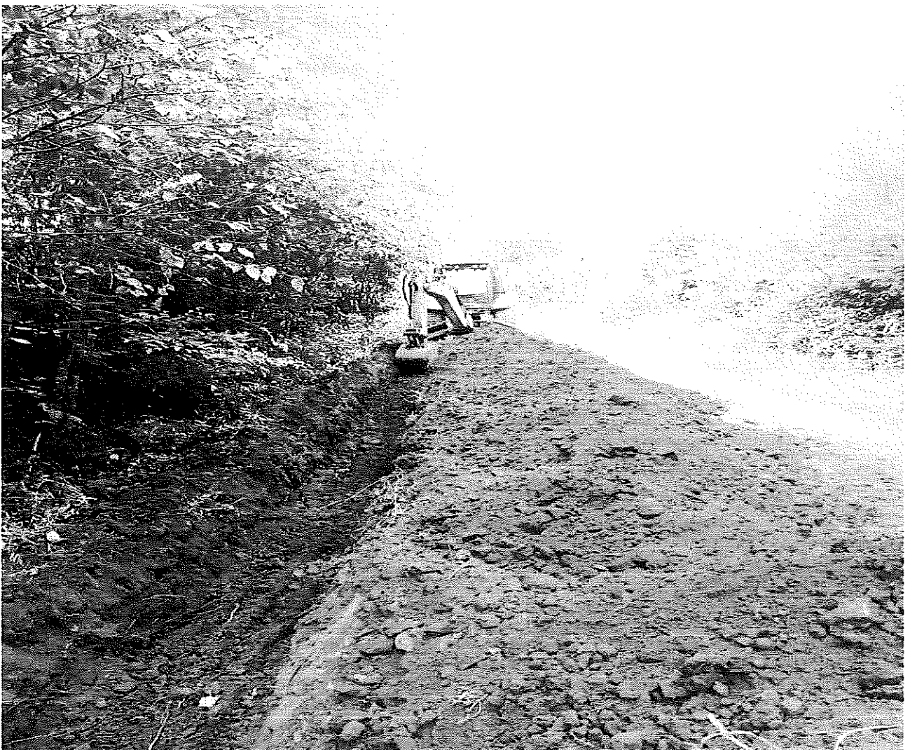
Foto 06 – Valetamento Rede água L. Sanga Castelhana
