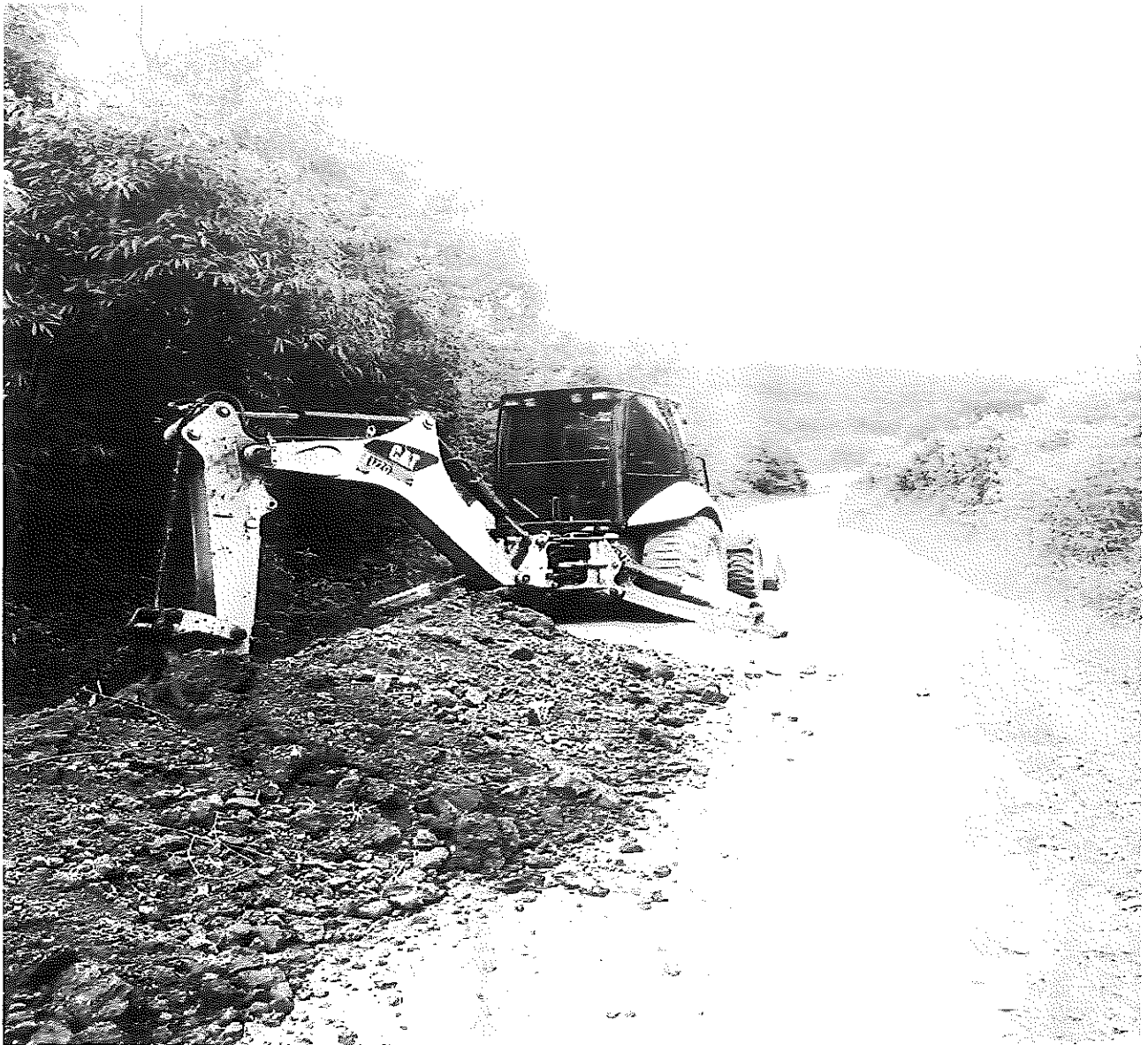
Foto 07 - Valetamento Rede água L. Sanga Castelhana
