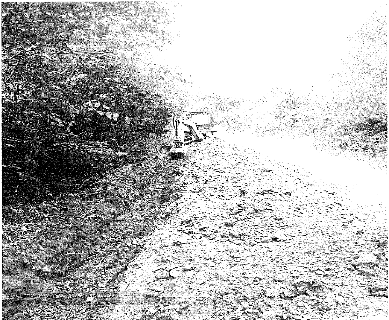
Foto 06 – Valetamento Rede água L. Sanga Castelhana
