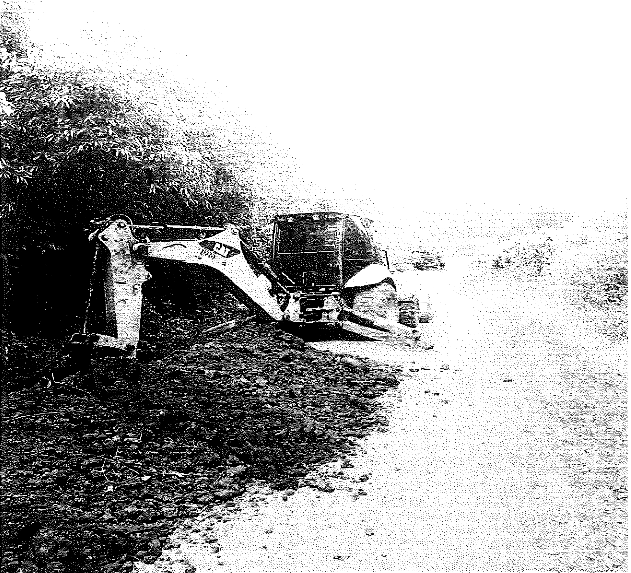
Foto 07 - Valetamento Rede água L. Sanga Castelhana
