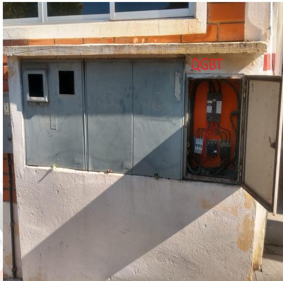
Após o disjuntor Geral deverá ser retirado o disjuntor central, que não está em funcionamento. Deverá ser verificado qual dos outros dois alimenta o Ginásio de Esportes (na qual deverá permanecer) e qual alimenta o Centro Administrativo (na qual deverá ser retirado de funcionamento).
